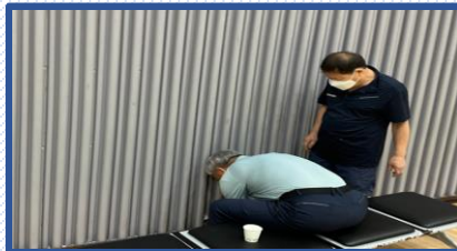
체육관 충격보호대 보수
