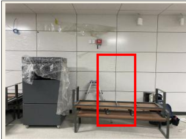
승강장 음료 자판기 설치 장소(하선 1개소)
